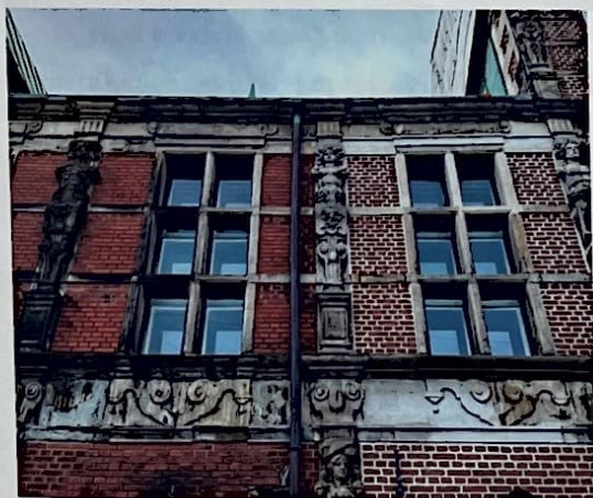
Facade med skalmur fra 1880'erne til venstre. Nyrestaureret facade med håndstrågne sten til højre. Foto: Albert Algreen-Petersen
