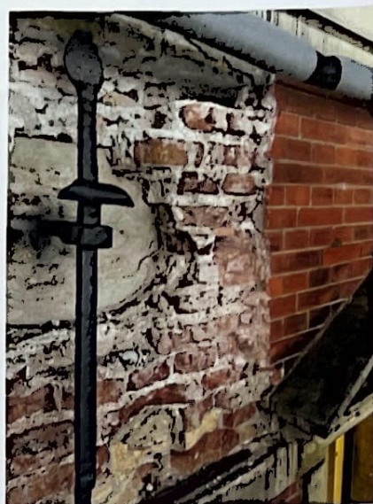
Teglskaller og cement hugges ned. Foto: Albert Algreen-Petersen
