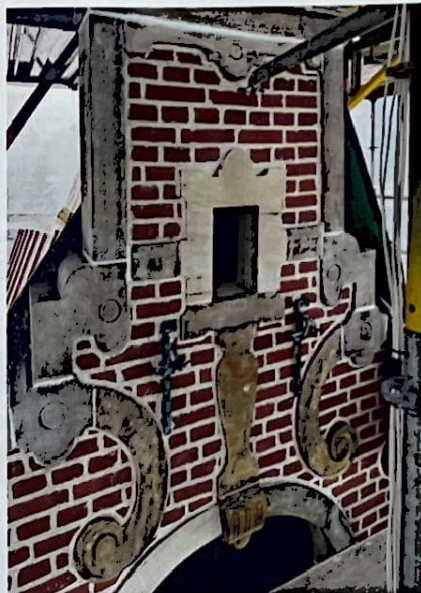
Nyopmuret gavkvist med håndstrøgne sten, nye sandstensdele og afrensede gamle sandsten. Foto: Albert Algreen-Petersen
